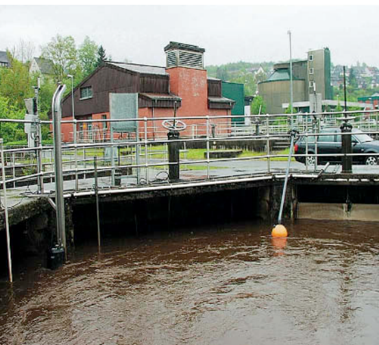
IM NACHKLÄRBECKEN: Bild 4 Einbau der NO 3 -N-Nährstoffsonde
