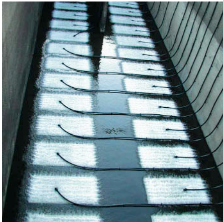
BLASENBILD: Bild 3 Der Plattenbelüfter nach der Montage
