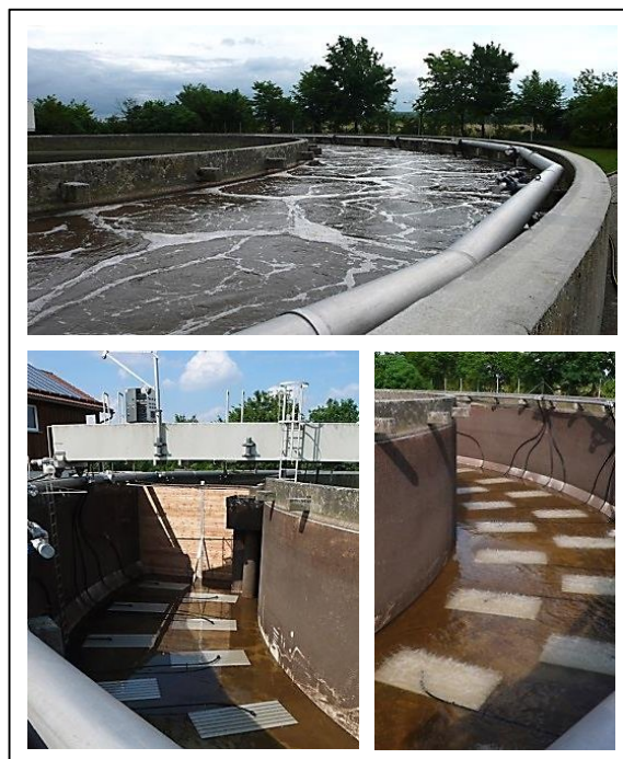
Abbildung 1: Belebungsbecken der KA Adelsdorf während und nach der Installation der MESSNER-Plattenbelüfter ® .
