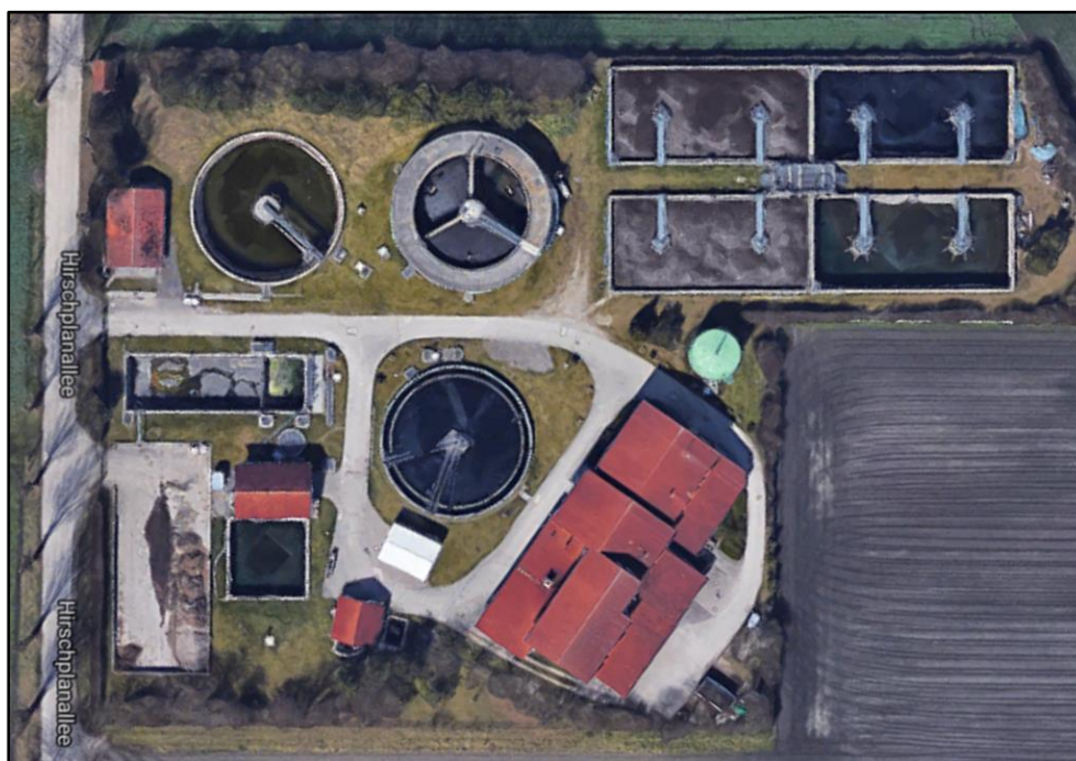
Abbildung 1: Luftaufnahme der Kläranlage Oberschleißheim
