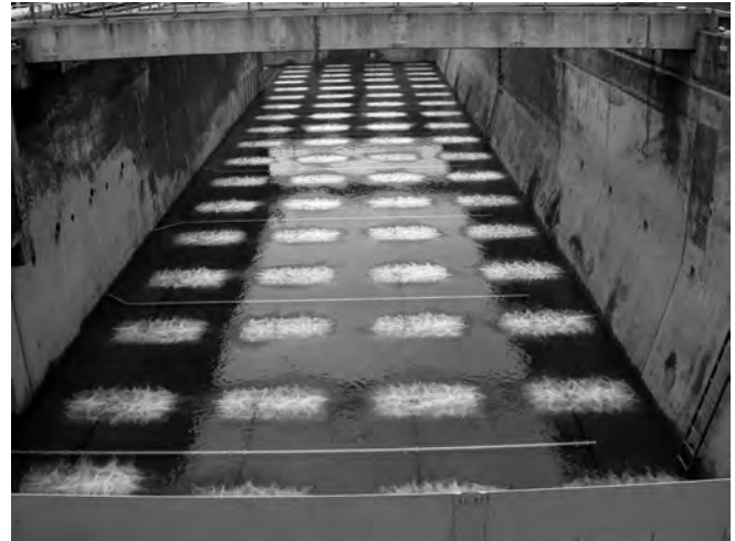
Abb. 2: Anordnung der Belüfterplatten nach Umbaumaßnahme
